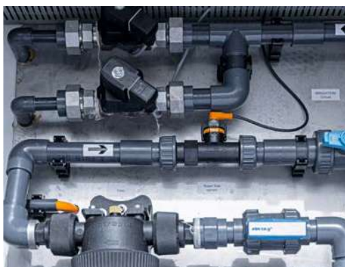
Los sensores de ifm supervisan el nivel de llenado, la temperatura y el caudal, tres factores que determinan la calidad de las plantas.
